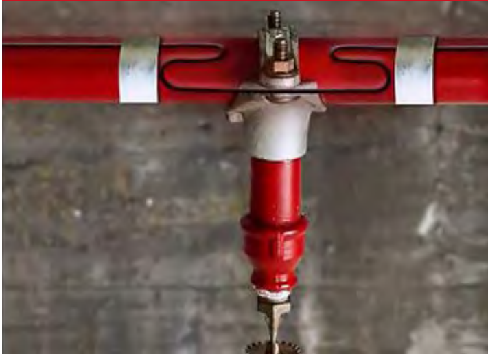
Antigelo e mantenimento in temperatura ARBT Cavo autoregolante
