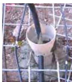
Predisposizione per il sensore in tubo Ø 100
