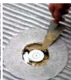
Posa del sensore e fissaggio con cemento
